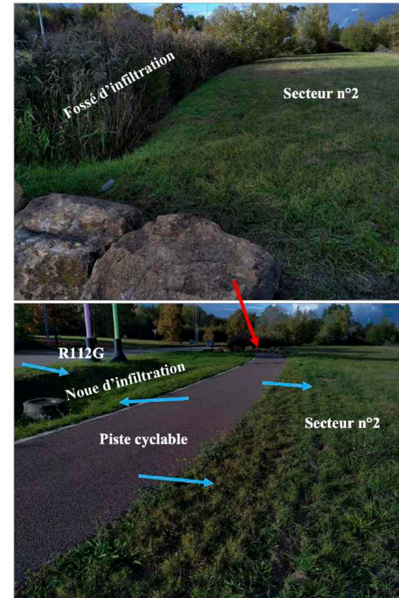
Figure 15 : Illustrations photographiques de la fin du fossé d'infiltration et de la piste cyclable, observés les 13 et 14 octobre 2021
